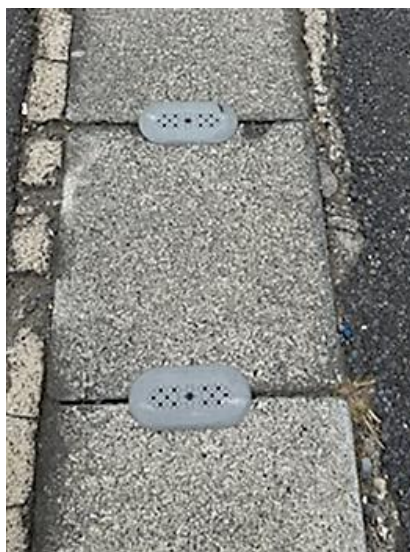
修復後 (撮影) 2月19日
