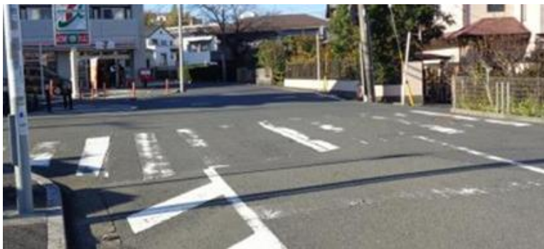
(改修前の状況 撮影2021年12月11日)
