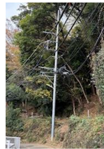
修復後の状況
