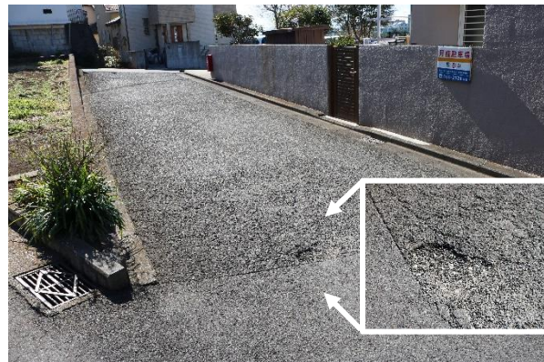
修繕前 (2023年2月21日撮影)
