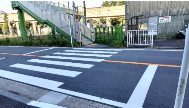
修復後の状況 (撮影2023年9月16日)
