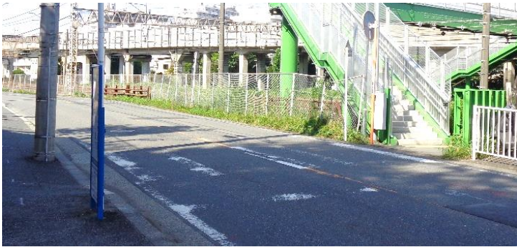
修復前の状況 (撮影2022年7月22日)
